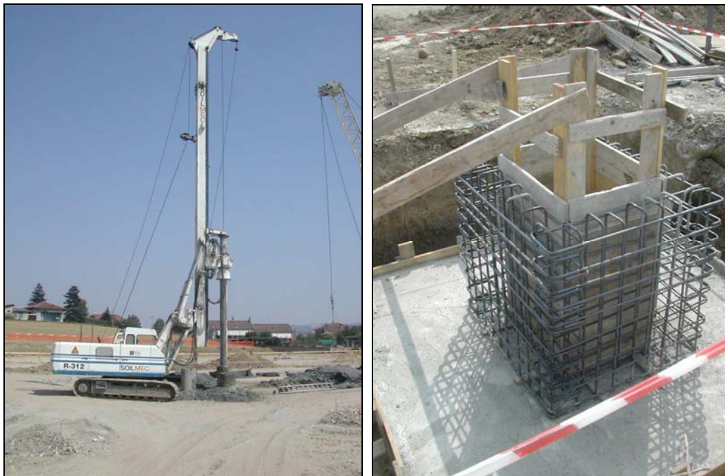
Trivellazione di pali in c.a. con portanza per attrito laterale e plinto sovrastante [Fornito da Oikos Engineering]
