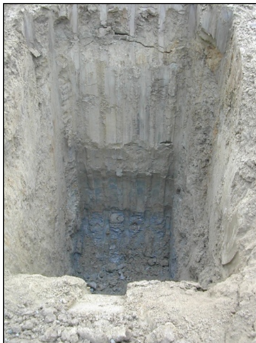
Pozzetto esplorativo eseguito da escavatore
