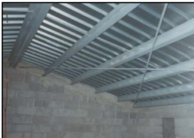
Copertura non spingente con struttura portante in acciaio e lamiera grecata.
