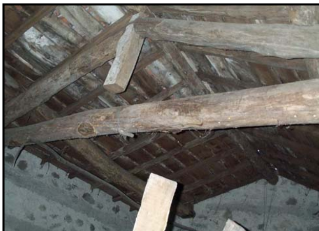
Copertura in legno non spingente con capriata.
