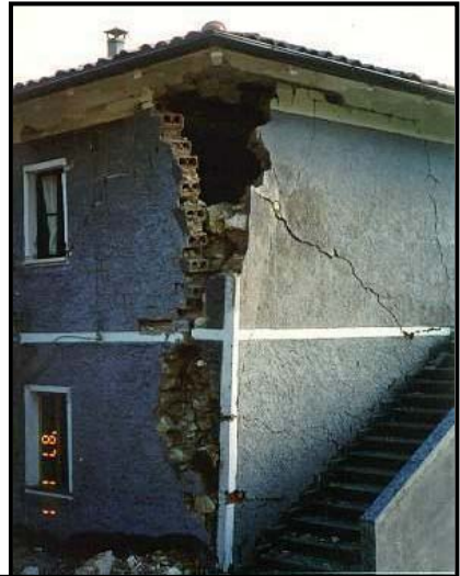
Danni provocati dalla spinta del puntone diagonale di una copertura a padiglione per effetto del sisma.
