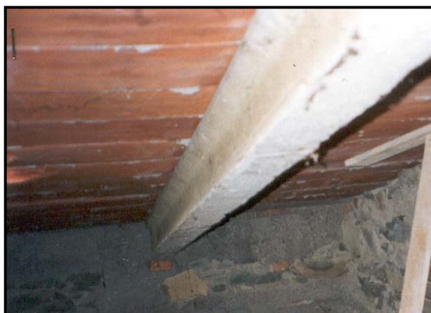
Copertura fragile e deformabile con travetti tipo Varese e tavelloni (120 cm) disposti in senso spingente.
