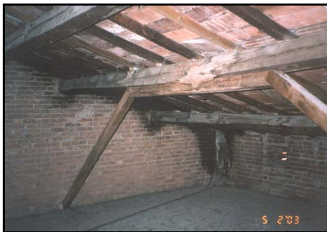
Copertura in legno con travi principali orizzontali.
